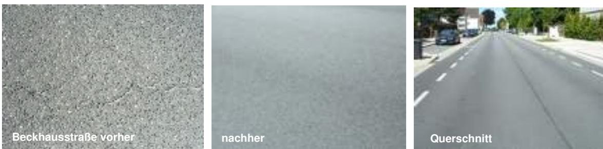
**Abb. 17: Lärmarme Fahrbahnbeläge**
