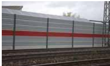
Quelle: DB Netz AG
