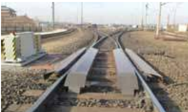
Quelle: DB Netz AG
