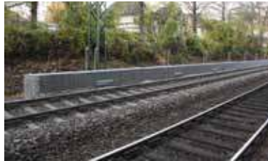
Quelle: DB Netz AG
