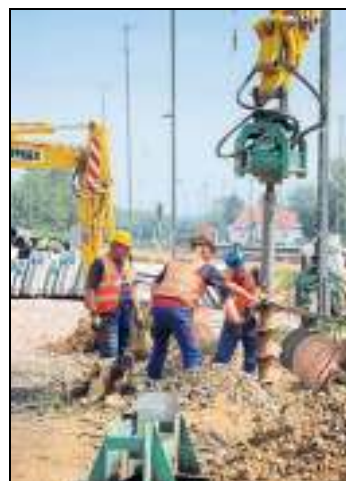
Erst werden mit Hilfe eines Baggers und eines Spezialaufsatzes Löcher gebohrt, ...
