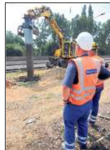
... bevor die Stahlpfahlrohre mit einem Vibrationskopf in den Boden gerüttelt werden.
