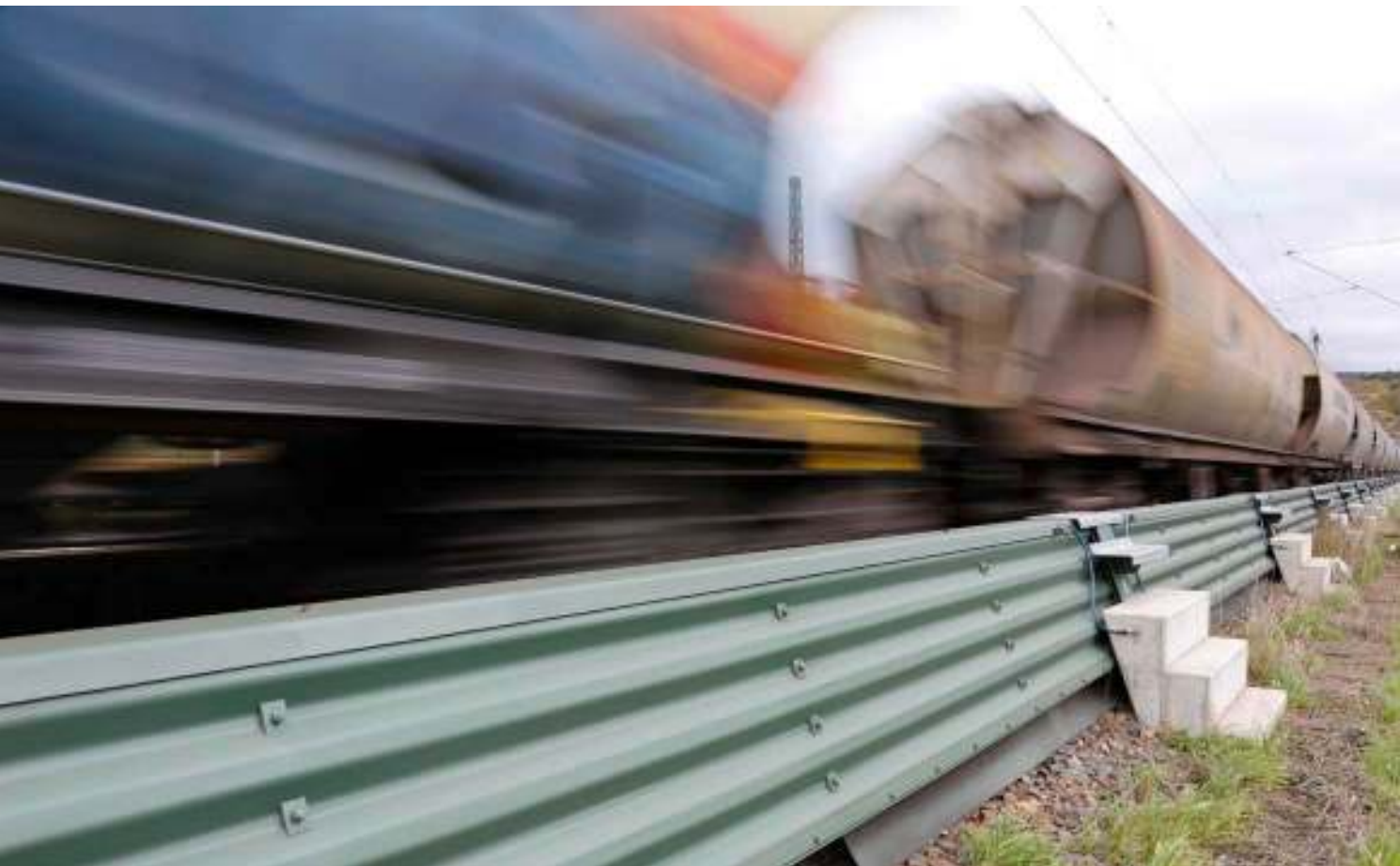
Niedrige Schallschutzwand in Osterspai im Mittelrheintal
