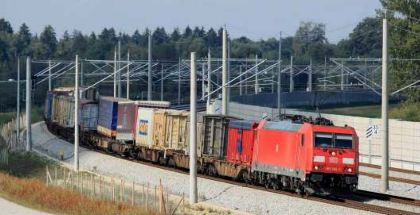
Schallschutzwand bei Hattenhofen
