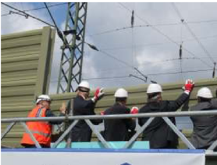
Foto 2: Einfügung letztes Wandelement zum Bauende Mai 2019
