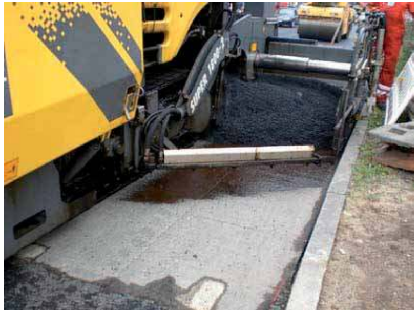
Bild 6: Einbau einer DSH-V, Quelle: Asphaltta
