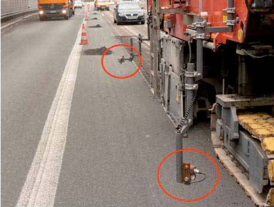
Bild 3: Fräsverfahren mit verbesserter Abtastung der Deckschichtoberfläche
