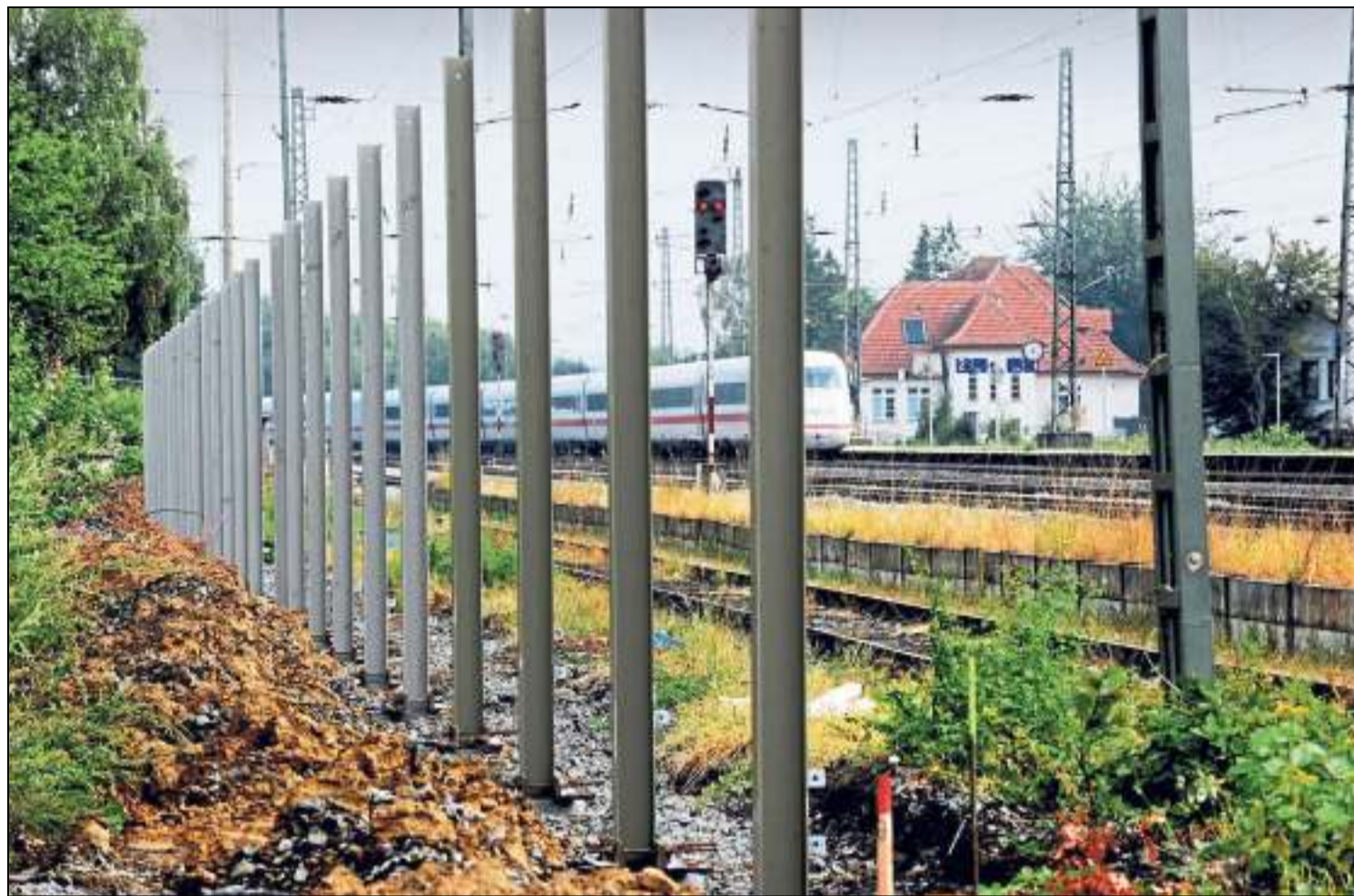
Die ersten Pfähle der neuen Lärmschutzwand stehen schon in Höhe des Braker Bahnhofs.
