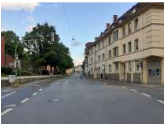
Schloßhofstraße, Blick von Melanchthonstraße nach Südosten
