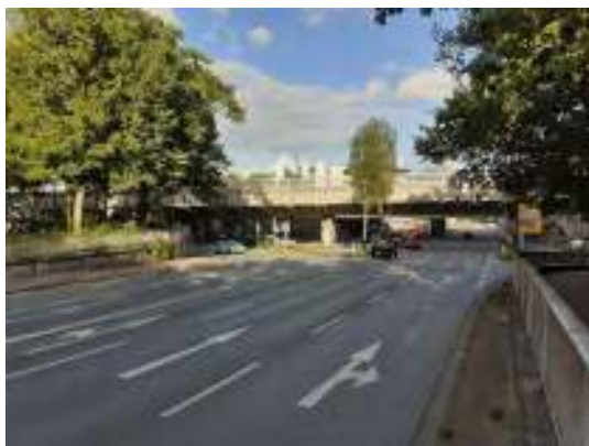
Stapenhorststraße, Blick von der Hausnummer 11 nach Südosten
